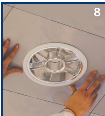
8 Install the fixture and tile into dropped ceiling 将安装好灯具的天花板重 新装进龙骨框架内，即可 完成安装。
